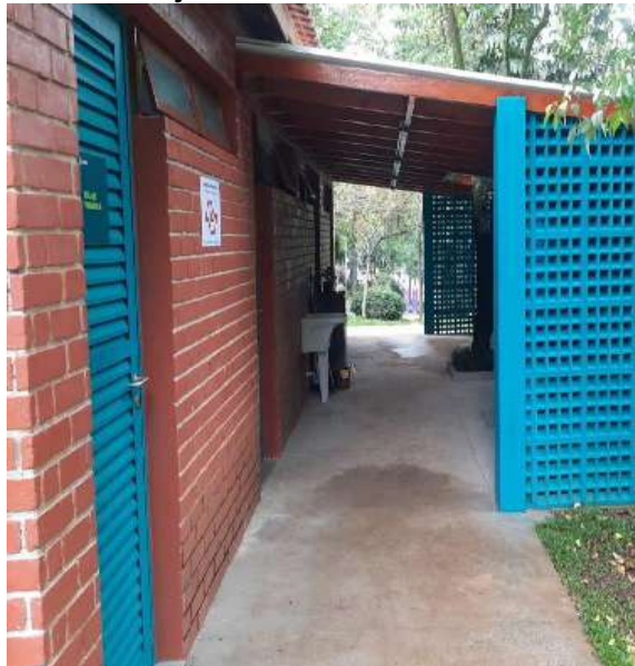
Figura 77 – Entrega das Obras do plano de Intervenções – Prédio Administrativo
