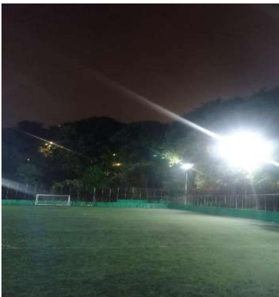
Figura 73 – Troca de postes do alambrado do campo
