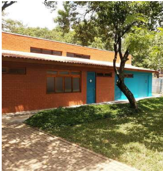
Figura 79 – Entrega das Obras do plano de Intervenções – Prédio Administrativo
