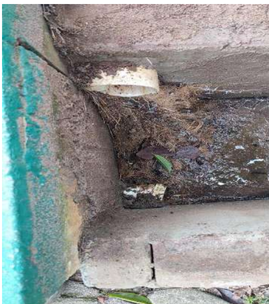
Figura 64 - Limpeza das caixas de passagem da nascente
