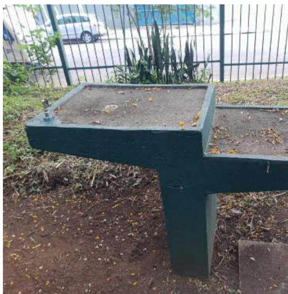
Figura 66 - Limpeza e pintura de bebedouros
