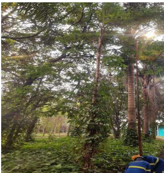
Figura 74 – Troca de postes do parque
