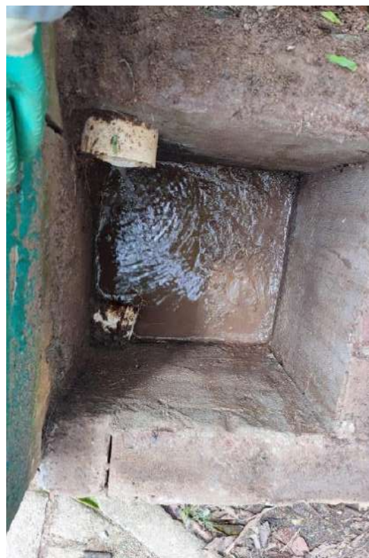
Figura 65 - Limpeza das caixas de passagem da nascente
