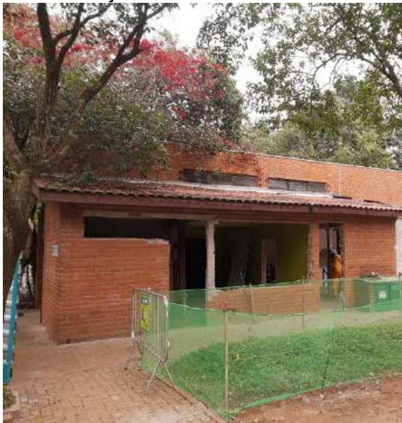
Figura 78 – Entrega das Obras do plano de Intervenções – Prédio Administrativo
